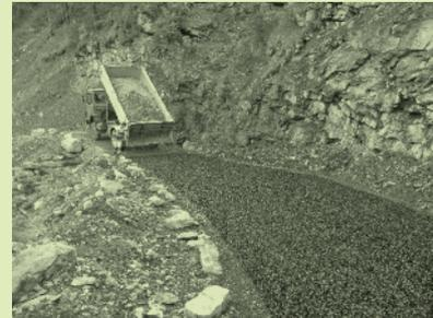
*Strassenunterhalt: Einbau eines Oberflächenbelages auf der Aelggistrasse*
