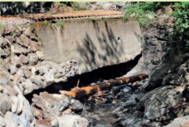
*Melchaatobel: Fahrbahnprovisorium, unterspülte Mauer, ausgehöhlter Strassenkörper*
