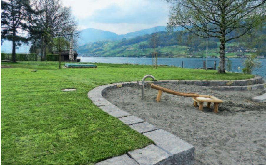
Im Winter/Frühjahr 2016 wurde im Rahmen des verabschiedeten Masterplans zur Aufwertung des Strandbads eine erste Massnahme umgesetzt. Angepasst an den natürlichen Verlauf der Uferböschung ist das südliche Ufer in Richtung Giswil saniert und mit einer Treppe aus Gubersteinblöcken neu gestaltet worden. Gleichzeitig wurde der Seezugang verbessert. Zusätzlich wurde der bestehende Sandstrand erweitert und durch ein Wasserspielgerät für die kleinen Gäste ergänzt.
