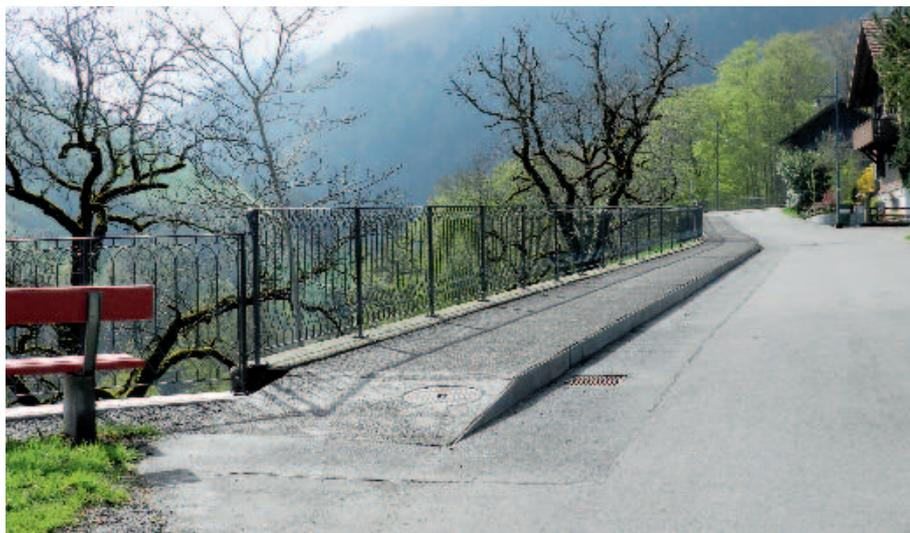
Der Gehweg entlang der Melchtalerstrasse im Bereich Schiblochrain wurde im Verlauf des Winters komplett saniert. Im Rahmen der Sanierung wurde auf die auskragende Betonkonstruktion eine Abdichtung sowie ein Gussasphaltbelag aufgebracht. Das Kantenschutzprofil entlang der Fahrbahn wurde erneuert und das Gelände ist ersetzt worden.
