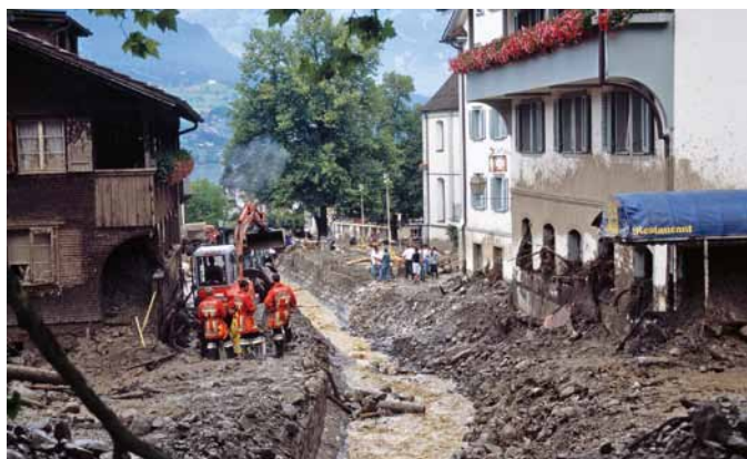
Die Fluten zerstörten das Restaurant im Hotel Kreuz.
