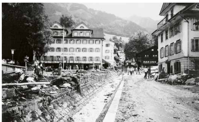
Die zerstörte alte Bachrinne unter dem Hotel Kreuz.
