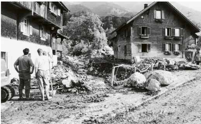
Der Edisriederbach übersarte die Älggistrasse.
