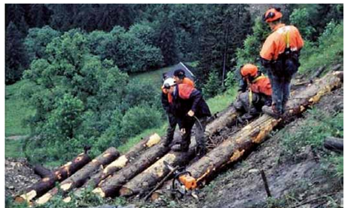
Die Hänge wurden mit Holzkasten gesichert.
