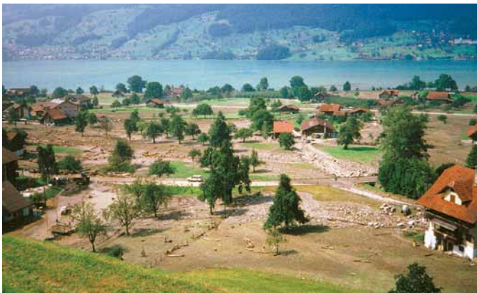
Stark beschädigt wurde auch Kulturland.
