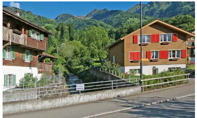
Das Haus rechts im Bild musste neu gebaut werden.
