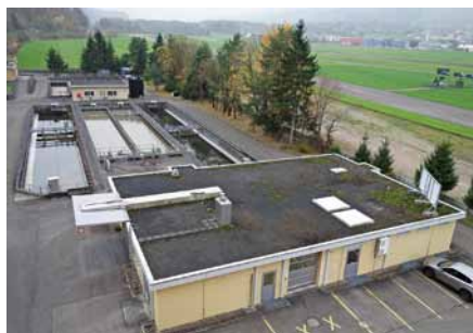
ARA vor Baubeginn.
