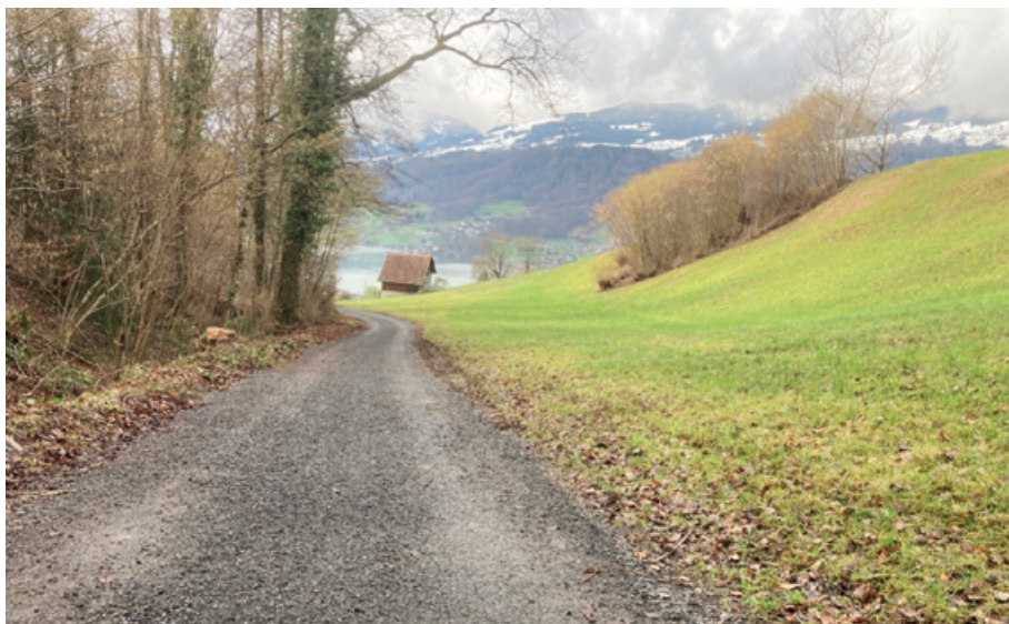
Sanierte Allmendstrasse zwischen Chalchofen und Emmetti.
