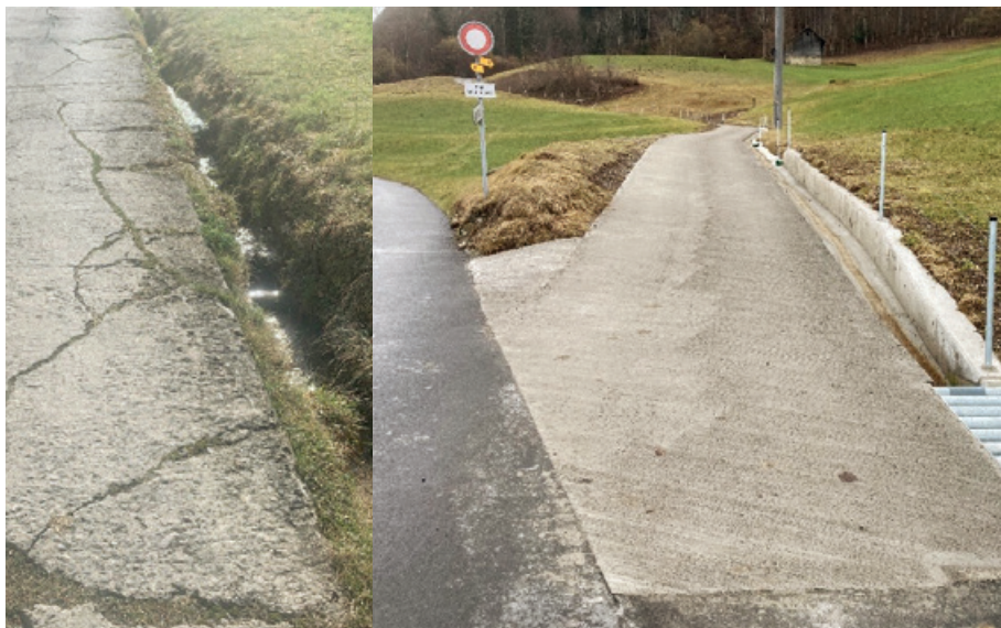
Teilstück der Haltenstrasse vor und nach der Sanierung.
